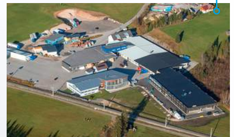
Bedrijfsuitbreiding van de vestiging in Kainisch: nieuwe productiehal met 3.000 m 2
